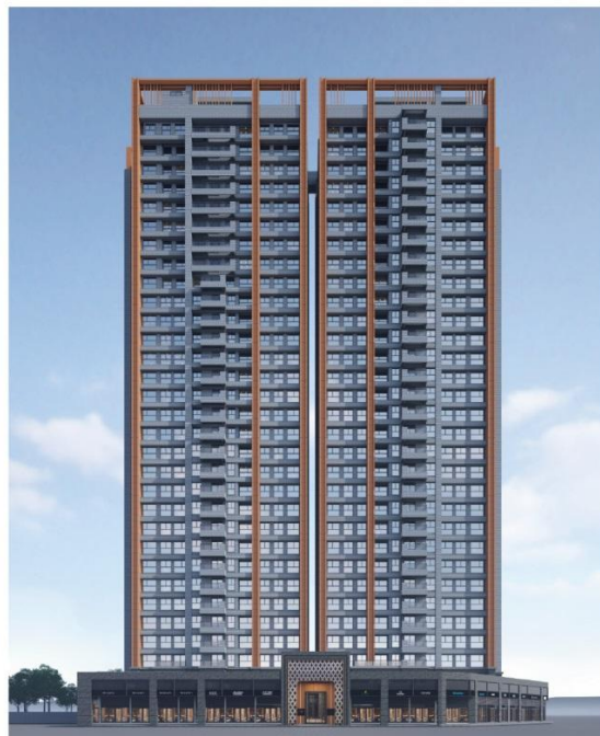
新北市板橋區 兆樸開禧 危老案
